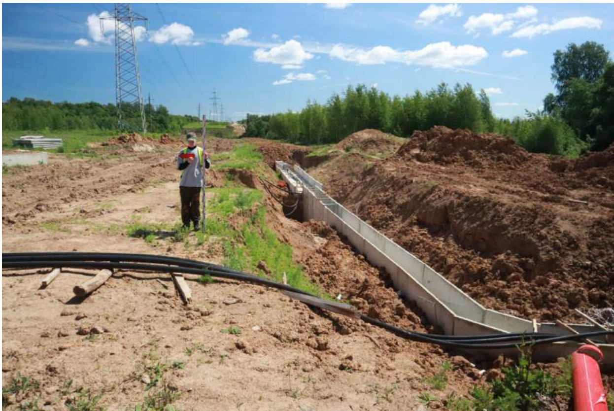
Рис. 27. Обеспечение сохранности ОКН федерального значения «Поселение Ольгинское» в г. Нижний Новгород. 2026 г. Участок проектирования. Точка фотофиксации 4. Вид с З.
