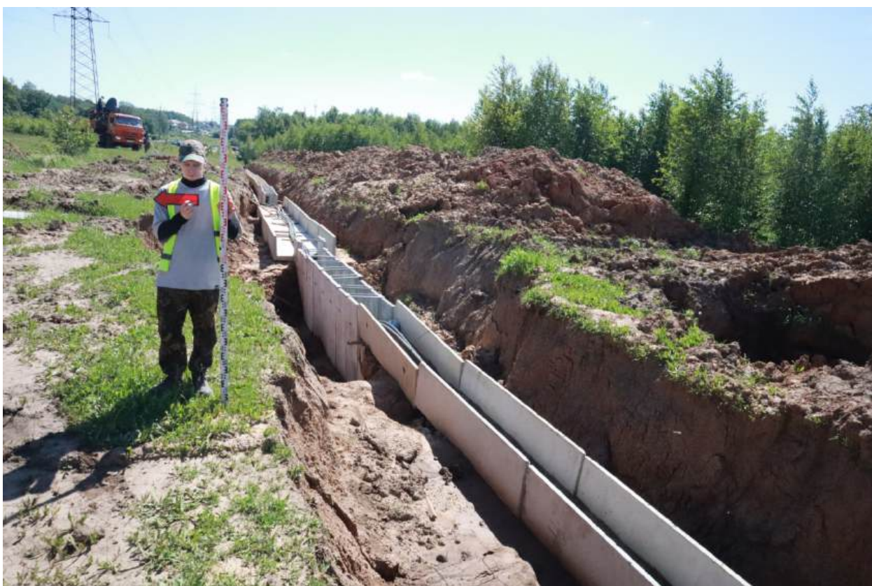
Рис. 24. Обеспечение сохранности ОКН федерального значения «Поселение Ольгинское» в г. Нижний Новгород. 2026 г. Участок проектирования. Точка фотофиксации 2. Вид с 3.
